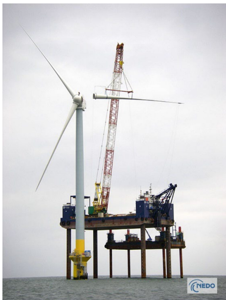
風車設置の様子
